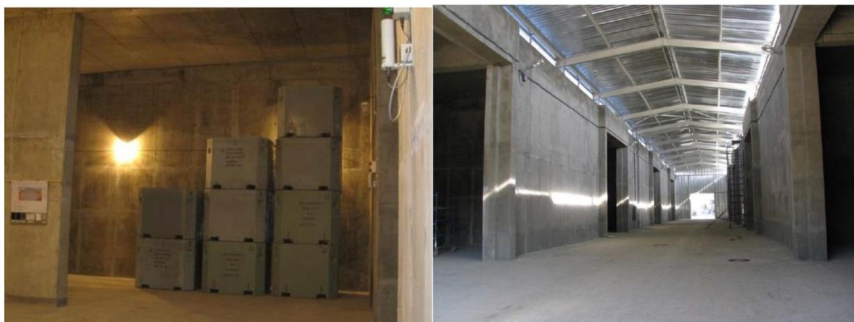
Рис. 2. Пример размещения цементных компаундов в подземных хранилищах (слева); специально оборудованный ангар для хранения отвержденных РАО (справа)
